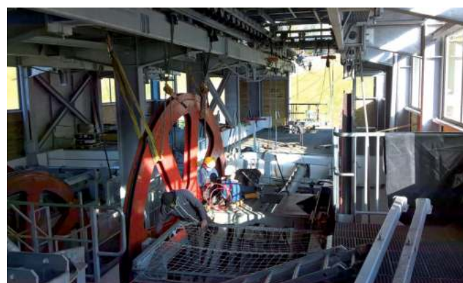
Mise en place des poulies de 5m60 de diamètre...
