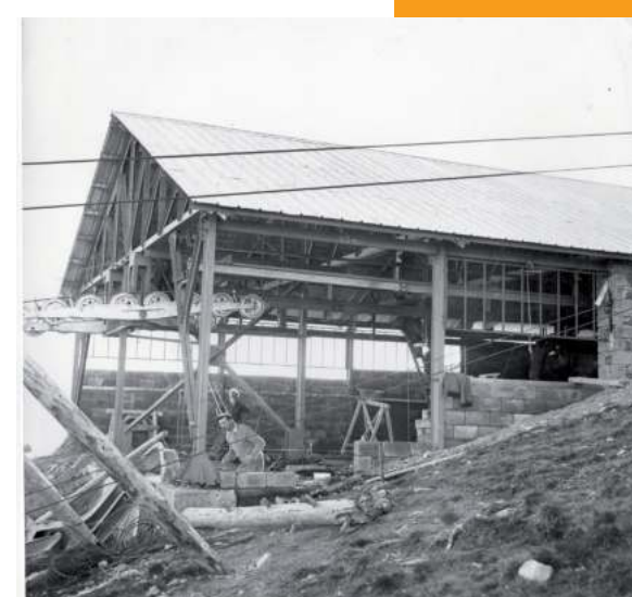
Construction gare téléphérique
